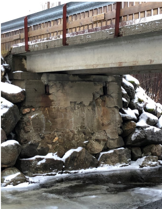
Figur 9 Bru over Tualva på Tuaveien.
