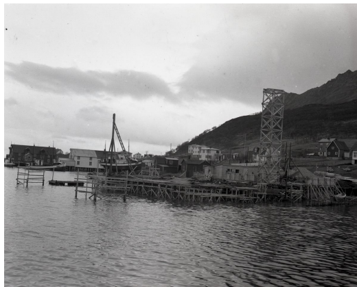
Bygging av Fryseriet i 1953. Foto: Skjegstad
